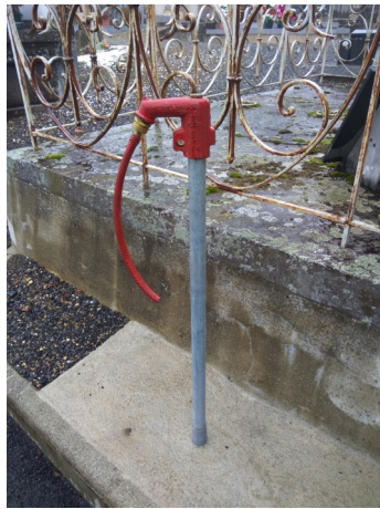
Installation d'un robinet d'eau au cimetière de Flat
